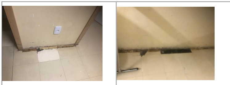
Figura 5 - Hospital Regional da Asa Norte - HRAN
