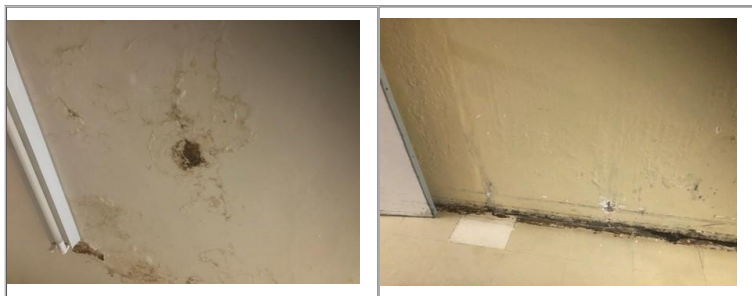
Figura 6 - Hospital Regional da Asa Norte - HRAN
