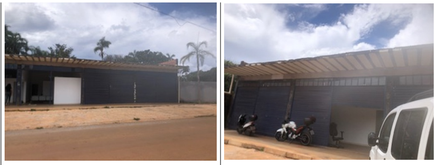
Figura 1 – Frente do imóvel
